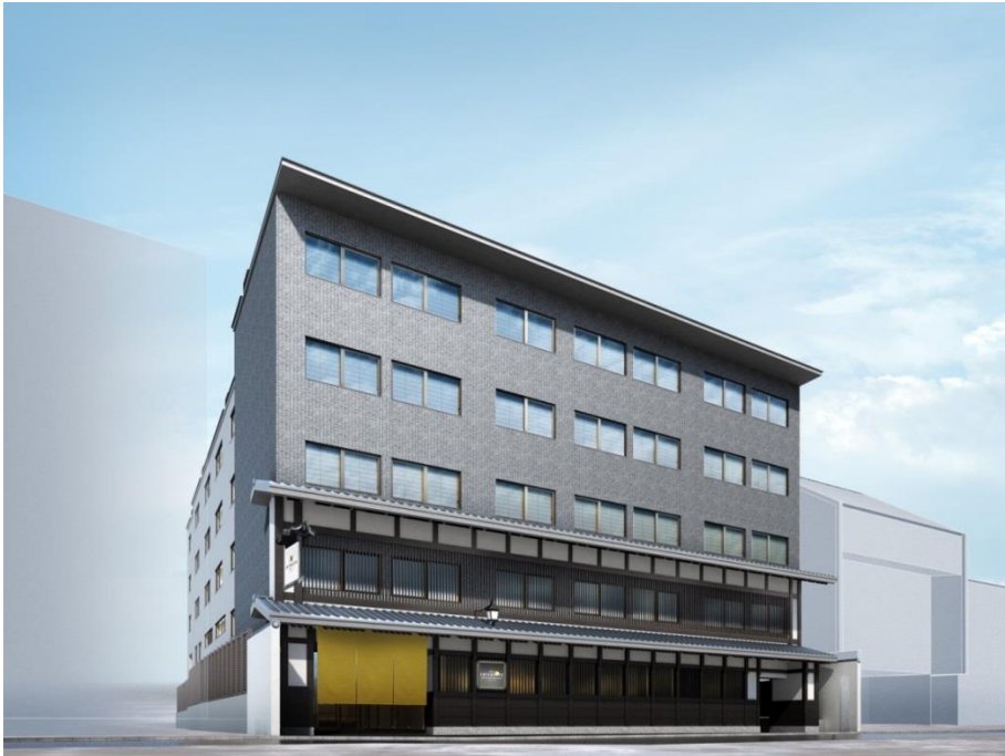
ホテルインターゲート京都 四条新町 京都府京都市中京区 S造、地上5階 153室 2018年3月開業
