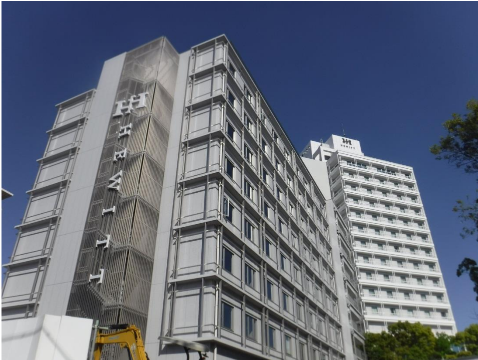
ホテルヒューイット甲子園 兵庫県西宮市甲子園高潮町 ・SRC造、地上14階地下1階、212室・・・既存棟 ・S造、地上8階、200室・・・新築棟 2018年7月末竣工(予定) ※共同事業
