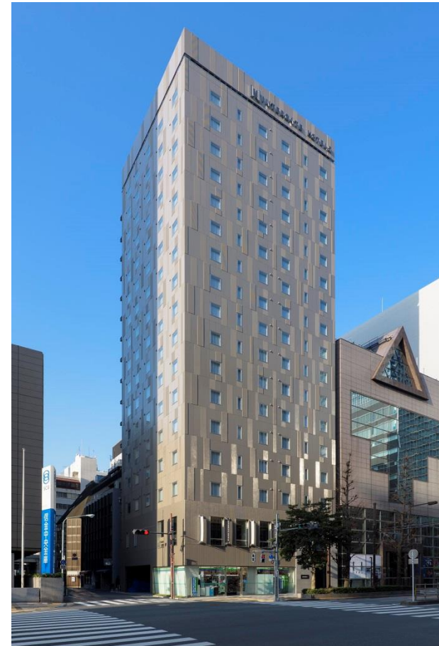
ホテルインターゲート東京 京橋 東京都中央区京橋 S造、地上17階 200室 2018年4月開業
