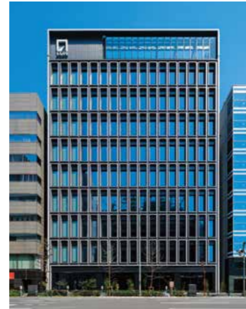
S-GATE大手町北
